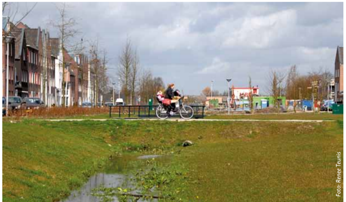
Nieuwbouw wijk in de Leidsche Rijn heeft een afwateringssysteem van het regenwater in een wadi
