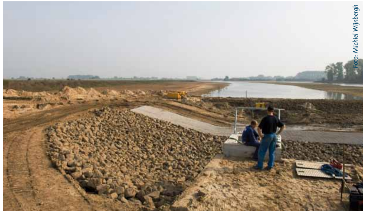
Werkzaamheden langs de Lek in het kader van Ruimte voor de Rivier, waarbij via een dijkverhoging met behulp van klei uit de uiterwaarden er meer ruimte komt voor water
